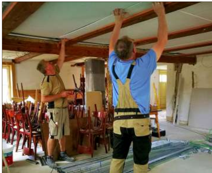
Die Handwerker Thomas Brix (links) und Wolfram Wohlgemuth beim Anbringen der neuen Zwischendecke im Versammlungs- und Veranstaltungsraum des Museums.
