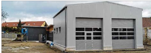
Die Fassade der neuen Fahrzeughalle für die Freiwillige Feuerwehr Börnecke ist fertig. Über den Winter geht der Innenausbau weiter voran. Foto: Holger Manigk
