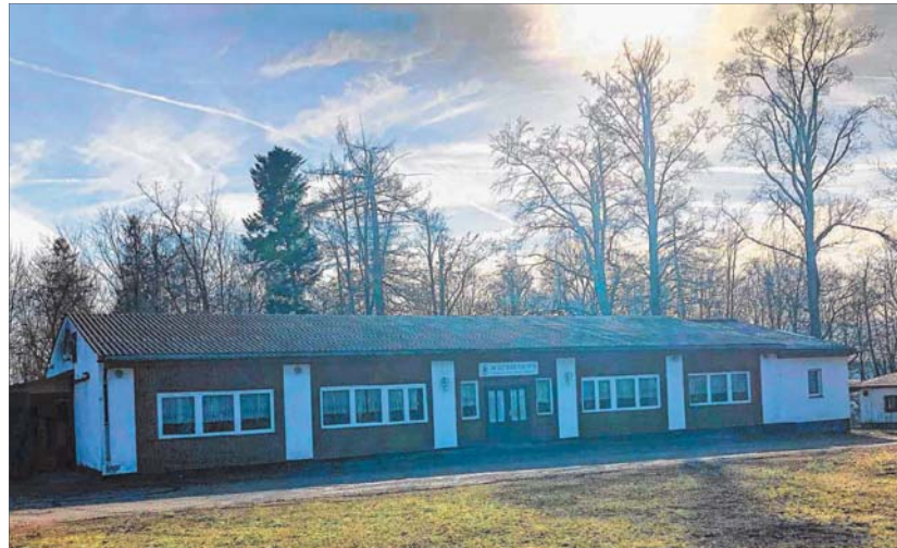
Das Dach des Schützenhauses in Stiege ist sanierungsbedürftig. Die Vereinsmitglieder hoffen auf Fördergeld aus dem EU-Förderprogramm Leader – die Chancen dafür stehen gut. Foto: Marko Brandt
