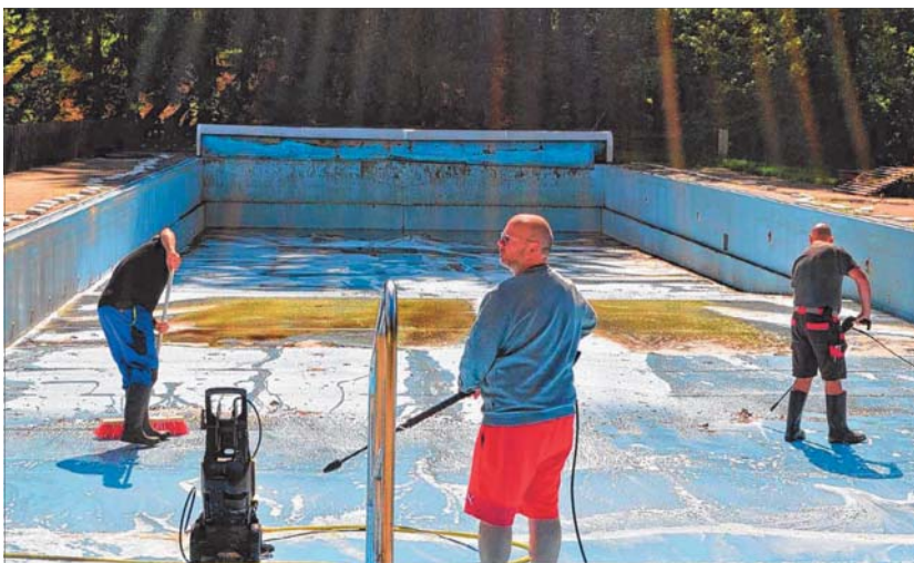
Bei der Reinigung des Hauptbeckens kamen Hochdruckstrahler zum Einsatz.
