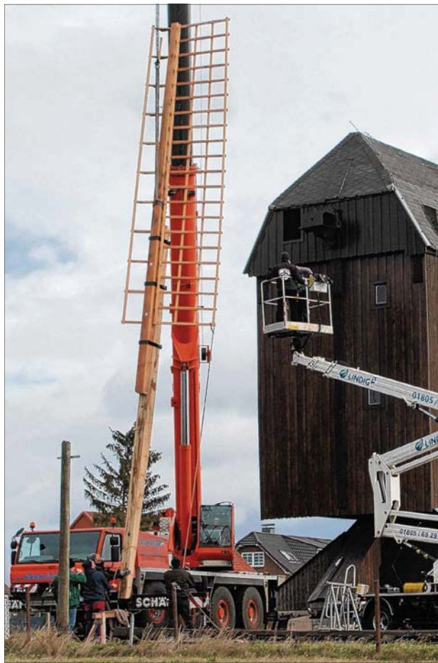
Die Windmühle in Danstedt bekommt neue Flügel. Die ersten zwei wurden gestern montiert, die beiden anderen sollen am heutigen Dienstag folgen. Foto: Jörg Niemann
